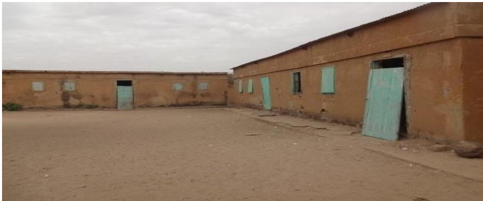
Figure 5: Vue partielle de l'Ecole I d'Adel Bagrou
