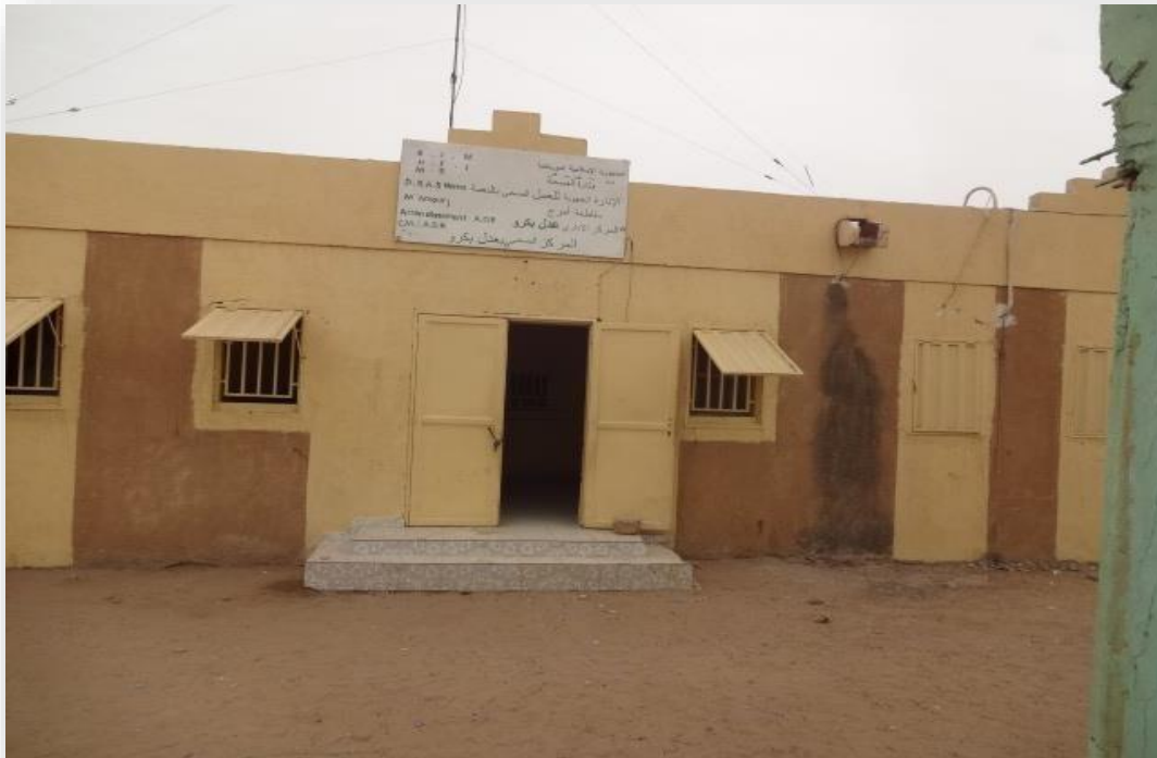
Figure 10: Vue d'ensemble sur l'état du Centre de santé à Adel Bagrou
