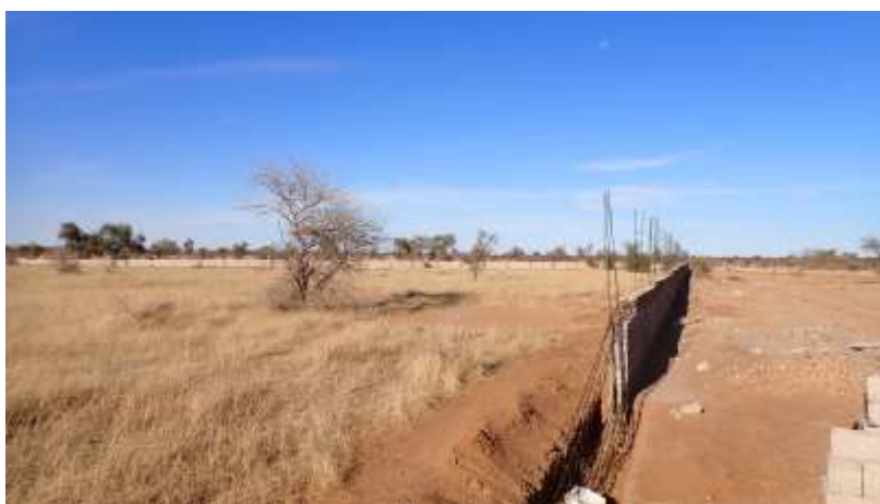
Figure 4 : Photo du site du CET
